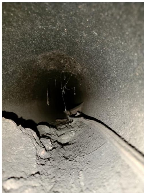
8 pav. Rūsio perdangos plokščių kiaurymė.
