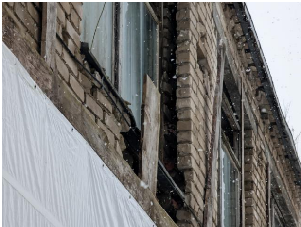
15 pav. Paradinio fasado rytinėje mūro sienos dalyje užfiksuoti išlinkiai bei lokalinis mūro suirimas.
