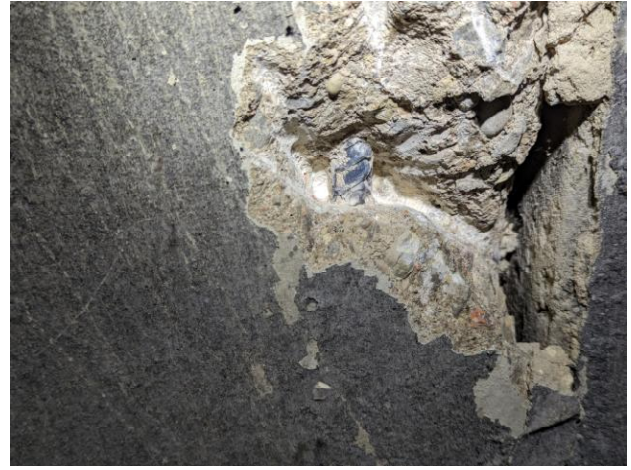
11 pav. Ardančiuoju metodu atidengta rūšio perdangos plokštės armatūra.
