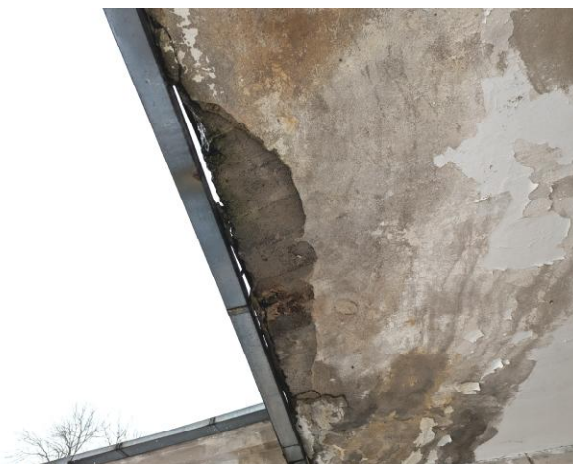
23 pav. Vietomis ties stogelio kraštu nukritęs betono apsauginis sluoksnis, armatūra atvira.
