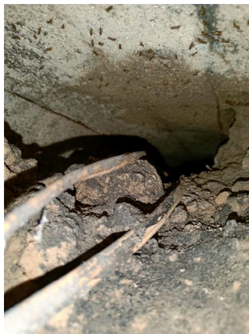
9 pav. Rūsio perdangos plokščių kiaurymė.
