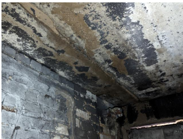
13 pav. Ant rūšio perdangos plokščių matomi drėgmės požymiai.
