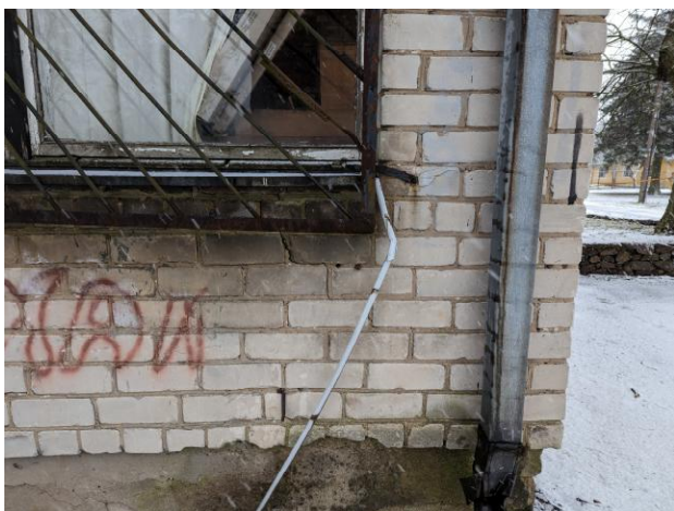
17 pav. Užfiksuoti nežymūs įstriži plyšiai ties pastato kampu.
