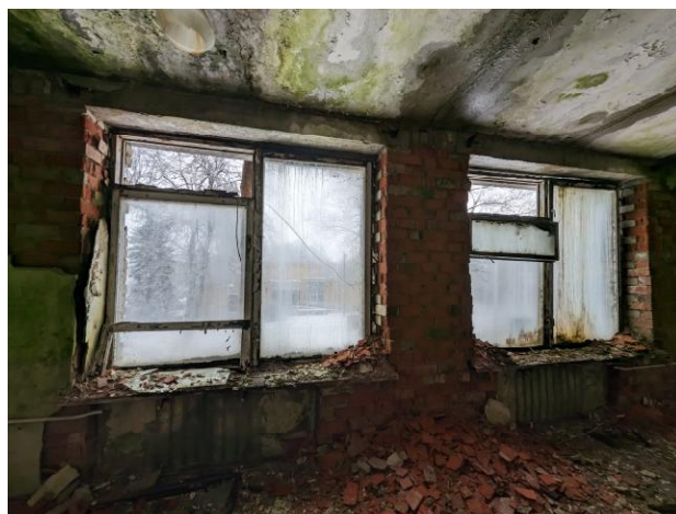
18 pav. Drėgmės pažeista vidaus apdaila taip pat plytų mūras iš vidaus pažeistas erozijos, ypač antro aukšto patalpose.
