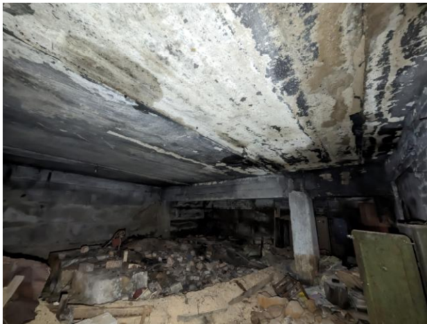
6 pav. Bendras rūsio patalpų vaizdas.
