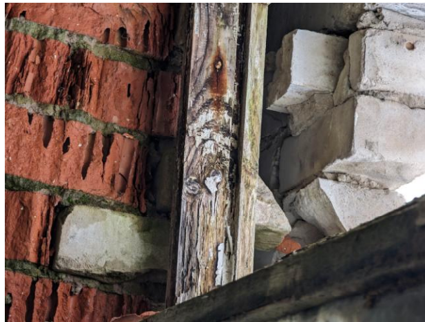
16 pav. Pastato rytinėje dalyje paradinio fasado mūro sienoje užfiksuoti išlinkiai bei lokalinis mūro suirimas.
